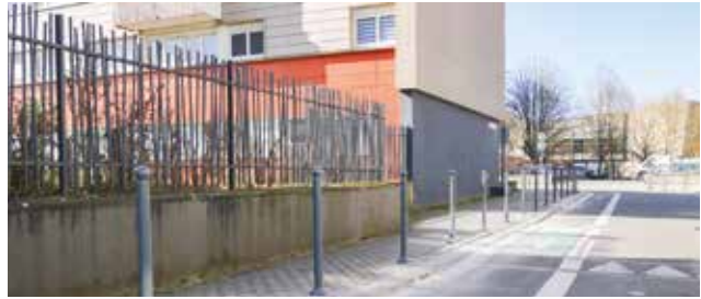
Des potelets sécurisants rue Chateaubriand.
