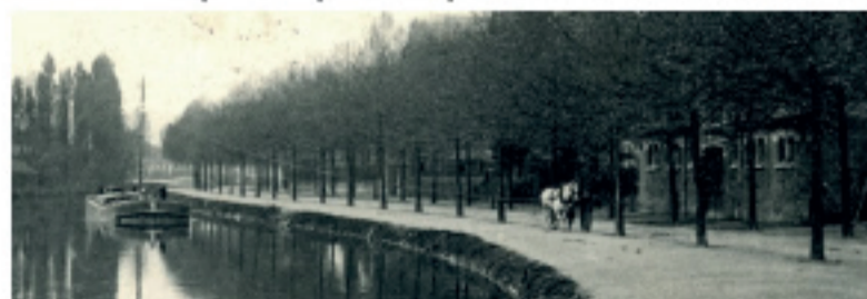
Extrait d'une carte postale de 1900 : les péniches en bois de type Freycinet, d'abord à voile, sont tirées par les familles de marins ou des chevaux, comme ici devant le n°36, avenue de Soubise. De 1927 à 1975, elles sont tractées par une locomotive électrique sur rail et motorisées petit à petit.
