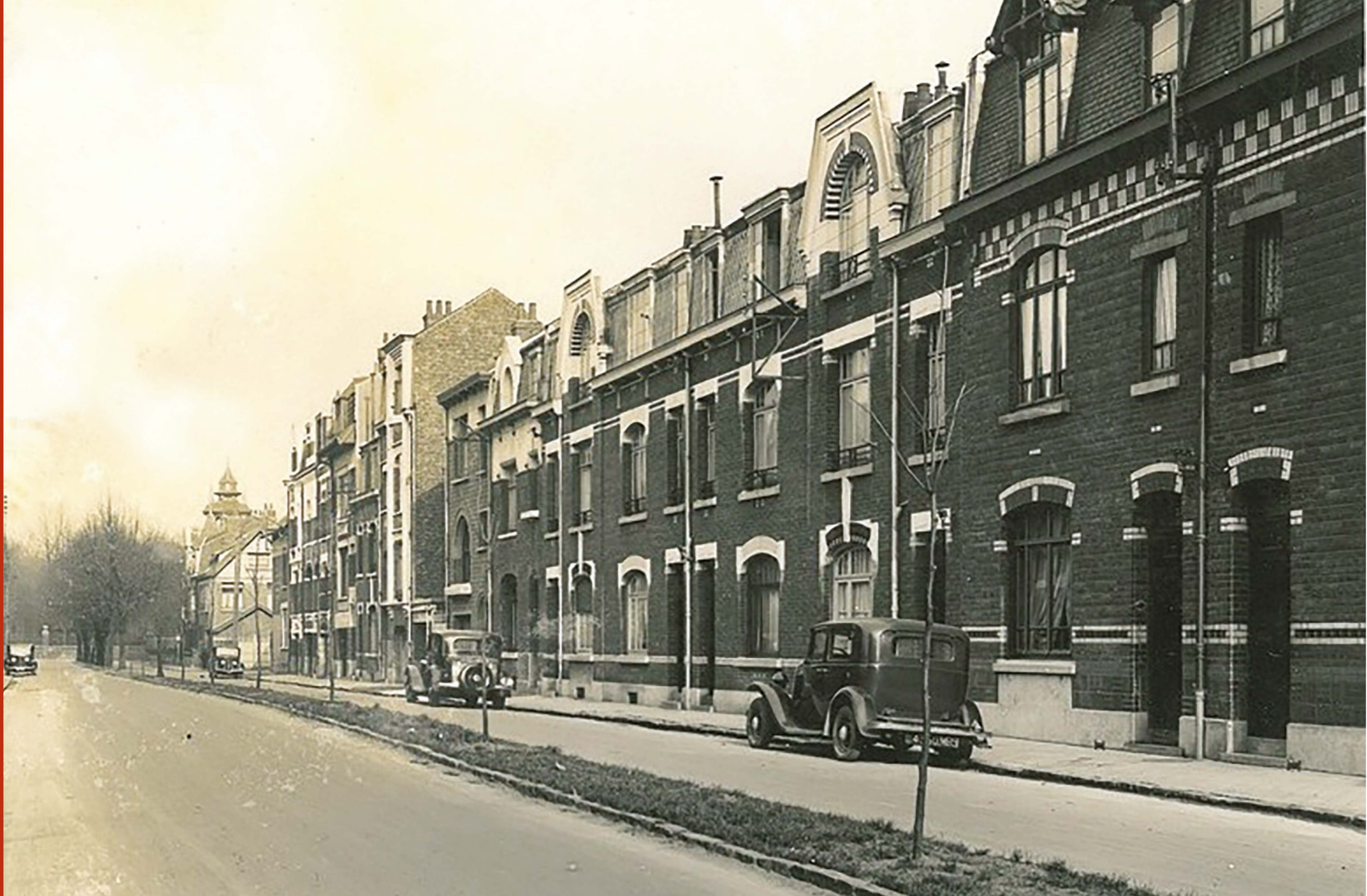
Photographie de l'avenue Bailly-Ducroquet vers 1932 : côté impair du n°35 au n°1 et château Dujardin-Scrive rue de Lille au fond
