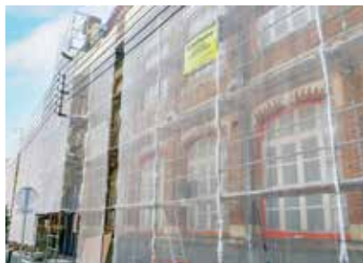
Rénovation de la façade de l'école Maintenon rue Champêtre
