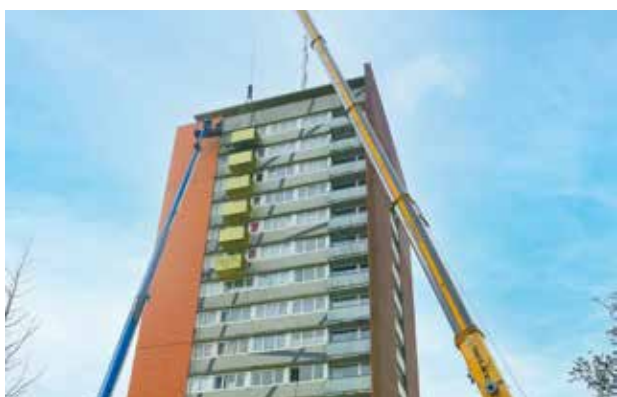
😊 Intervention spectaculaire : la rénovation des quatre tours du Pacot avance... Fin mars et début avril, de grands engins sont intervenus pour enlever les balcons des tours Fauvettes et Roitelets.
