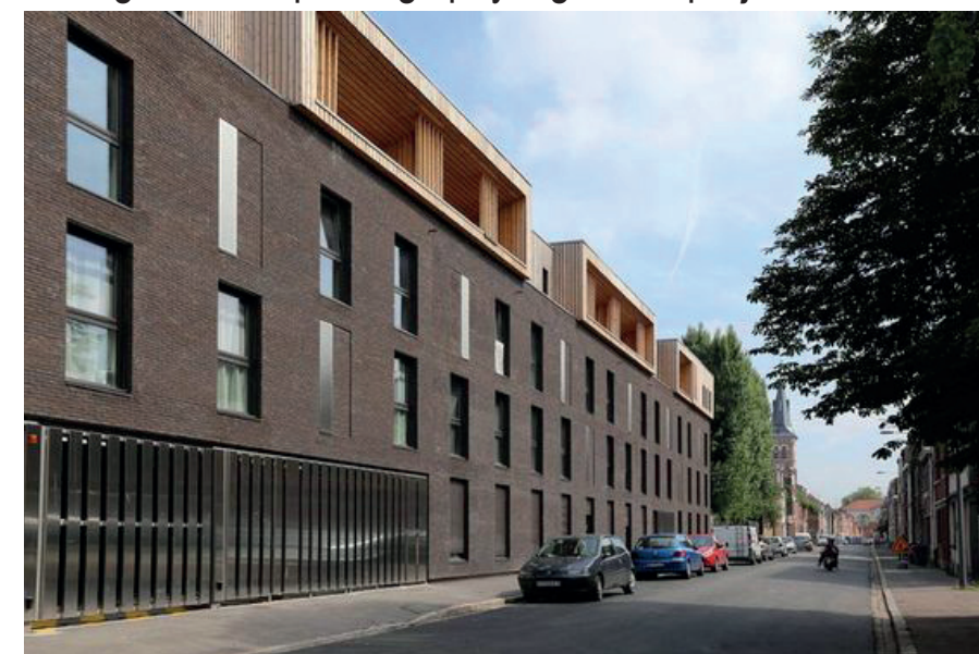
Des stationnements semi-enterrés
