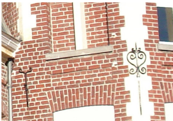
Fers d'encrage en fonte sur la tour
