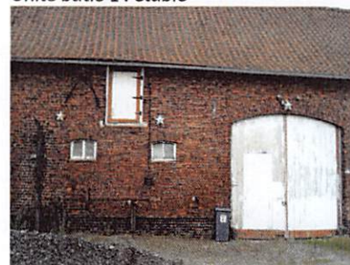
Unité bâtie : détails authentiques de façade
