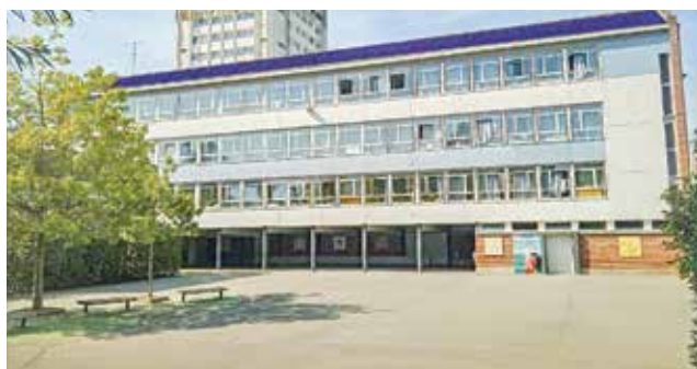
• Transformation progressive des cours des écoles : 140 000 €
